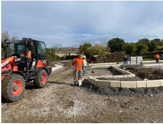
Travaux du parking du Lavoir
